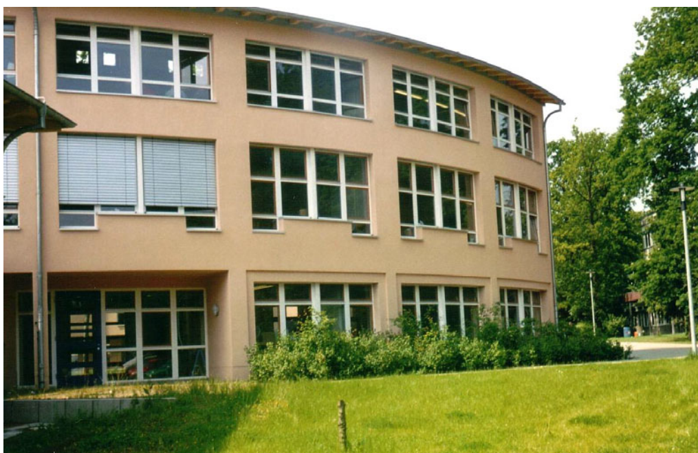
Eines der neuen Schulgebäude der Birger-ForellRealschule
